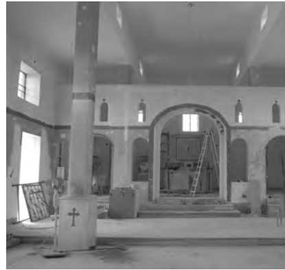
Die syrisch-orthodoxe Kirche in Sadad im Mai 2015; sie wurde schwer beschädigt, als die Stadt im Oktober 2013 rund eine Woche von der Al-Nusra-Front und der Freien Syrischen Armee besetzt war (© Christian Solidarity International).
